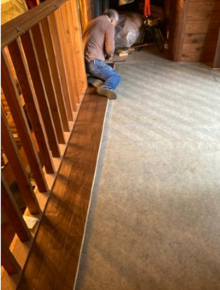
を仕上げている、同じ材料が無くなってきて、色合いの異なるフローリングを使用しますが、あわせの部分（サネ）が少し違うので板を合わせるのが難しい。14時ごろに北側完成。
